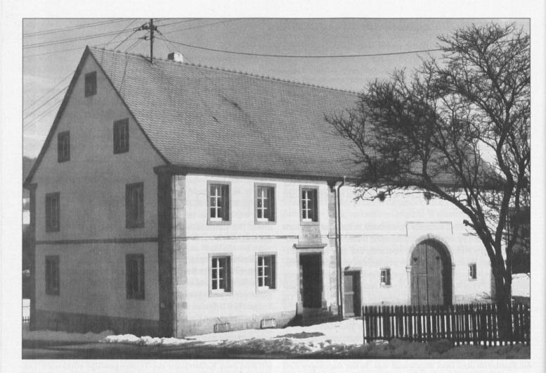
gegliederten Außenfassaden haben Natursteinfenster und -türgewände, sowie Eck- und Mittelisenen. Ein umlaufenden Gurtgesims – über dem Scheunenteil in abgekröpfter Form – ist vorhanden. Das Dach war ursprünglich mit Naturschiefer eingedeckt, Dachrinne und Fallrohre fehlten. An der rechten Giebelseite befand sich ein Trockenabort sowie ein Schuppen mit Pultdach, worin Ackergeräte aufbewahrt wurden. Ein Hausgarten lag vor dem Gebäude.
