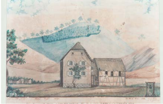
Pfarrhaus mit Strohkirche und Glockenstuhl außerhalb
