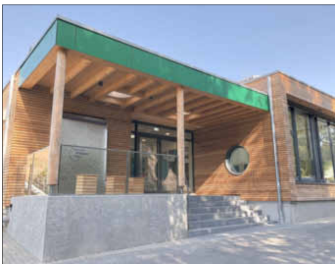
In Kempfeld an der Steinbachtalsperre liegt das Ausstellungsgebäude.
