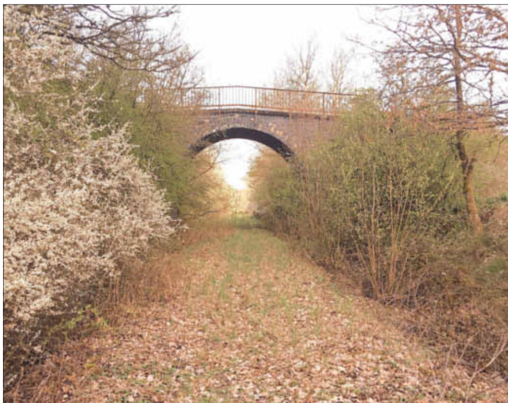
Viele Brücken auf der Strecke des Freizeitwegs müssen saniert werden. Das Foto zeigt die Brücke zwischen Asweiler und Wolfersweiler, die Gleise sind auf diesem 1. Abschnitt bereits demontiert. Foto: pdk
